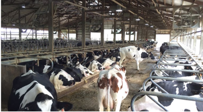
Figura 2: En un granero con ventilación natural, los ventiladores sobre las casillas dirigen el aire en movimiento rápido sobre las vacas mientras descansan. Foto de "The Dairyland Initiative."
